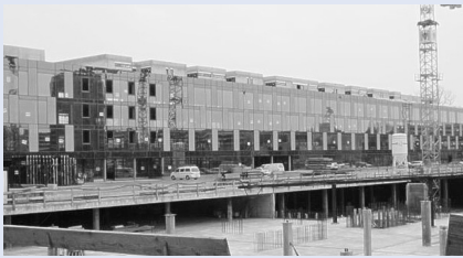
Rundgang durch die eindruckliche Baustelle des Wankdorf Stadions
